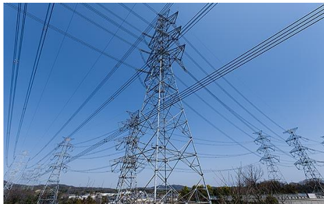
電力鉄塔（出所：関西電力株式会社）
